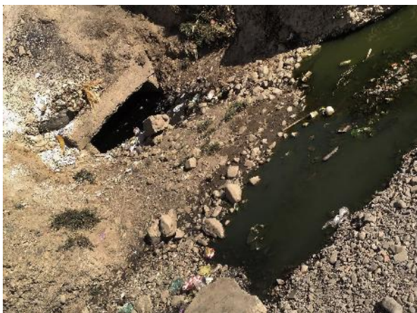
En la foto se ve un canal de aguas servidas que llegan al río. El mal olor de este lugar es muy fuerte.
