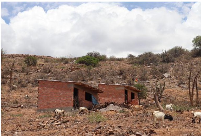
Casas ya construidas sin habitantes en los terrenos loteados, son edificaciones precarias sin servicios básicos.
