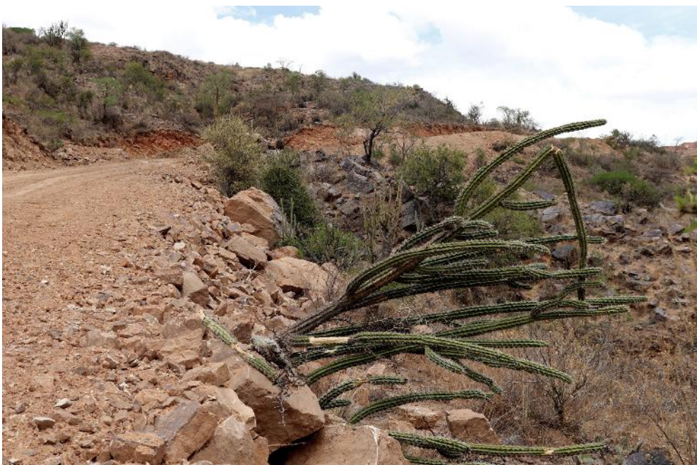
Camino abierto con tractores por loteadores que avasallan tierras en Santa Rosa de Lima.
