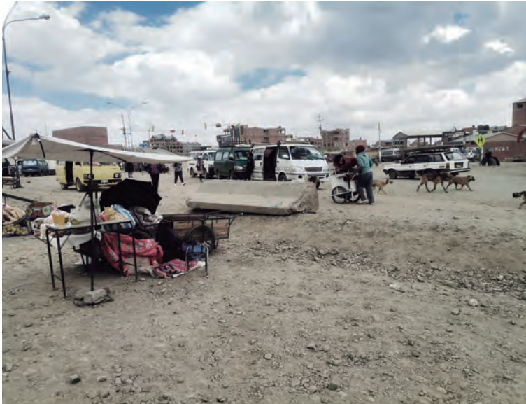
Vendedora de jugos de la avenida Integración, afectada por escombros de la construcción del nuevo puente.
