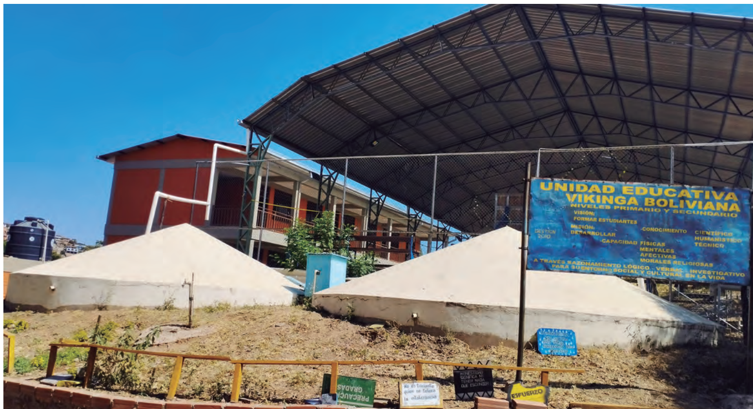
Tanques de agua y sistema de reciclaje en el colegio "Vikinga Boliviana", ubicado en la zona Cerro Verde, Distrito N° 6, municipio Cochabamba.
