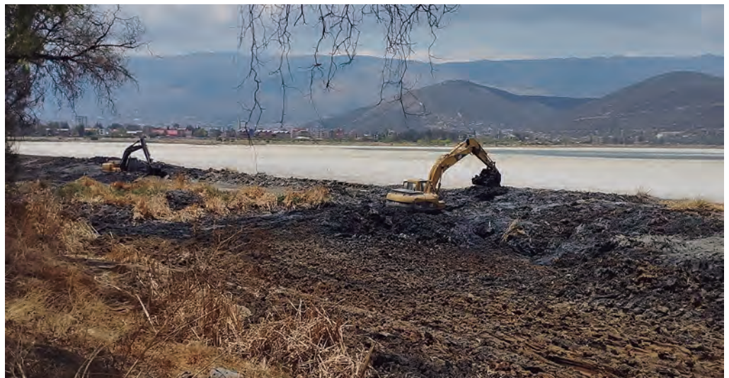
Foto tomada el año 2023, cuando se realizaba el trabajo del dragado de la laguna, que es la extracción de lodo, piedra y materiales orgánicos putrefactos.
