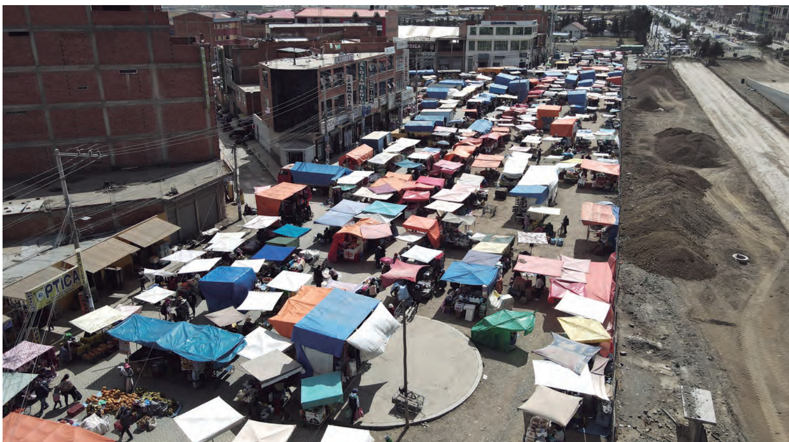
Vista panorámica del mercado de Senkata, ubicado junto a la construcción del nuevo puente de la zona.
