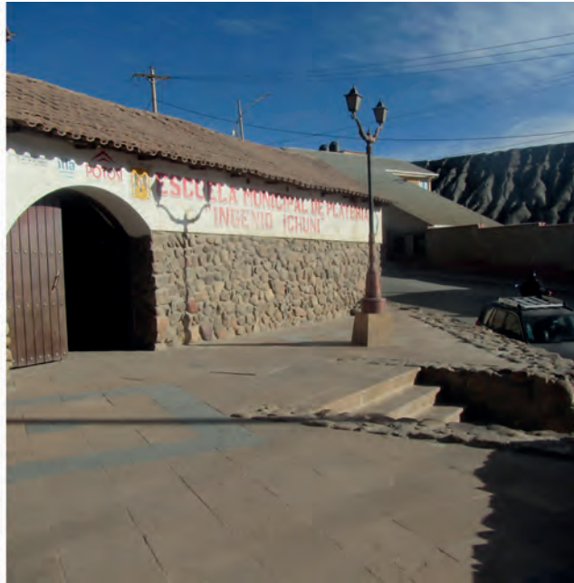
Detalle de una de las barreras del dique de colas que se rompió por envejecimiento y dejó salir material tóxico. Al lado se ve la cercanía del dique de colas con la Escuela Municipal de Platería.
